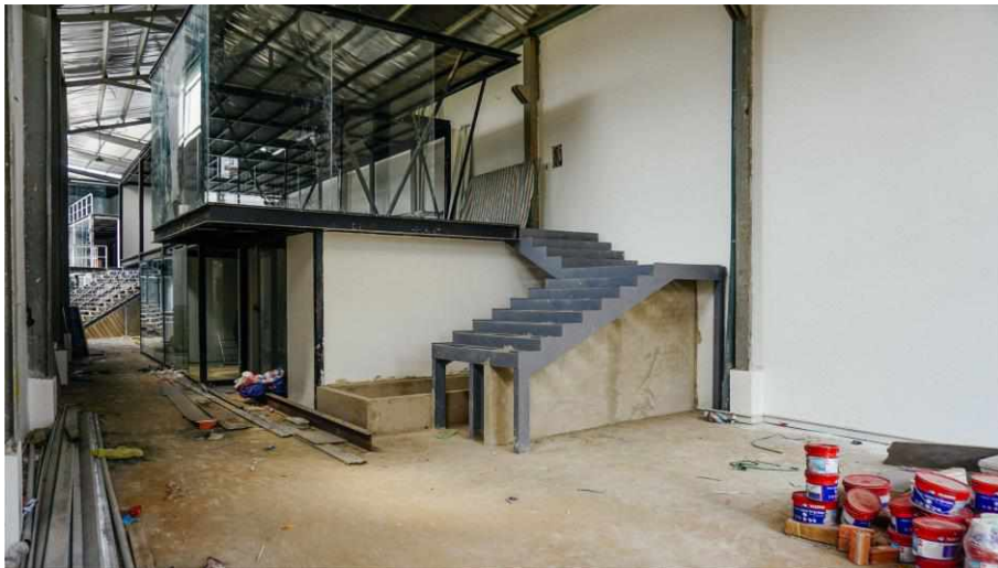
Hình 1.2 Hiện trạng xây dựng công trình
